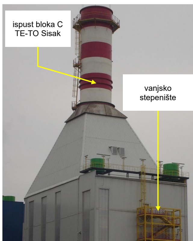
Sl. P 1: Ispust dimnih plinova i kotlovnica bloka C TE-TO Sisak
