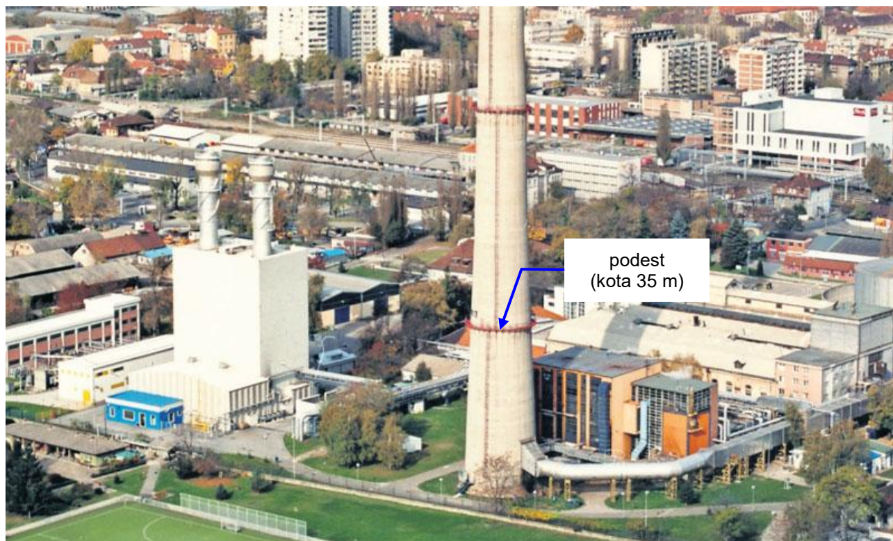
Sl. P 2: Položaj podesta na koti 35 m glavnog betonskog dimnjaka EL-TO Zagreb
