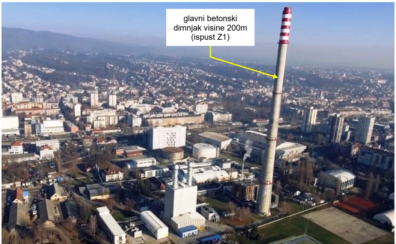
Sl. P 1: EL-TO Zagreb i glavni betonski dimnjak (zajednički ispušt dimnih plinova Z1)
