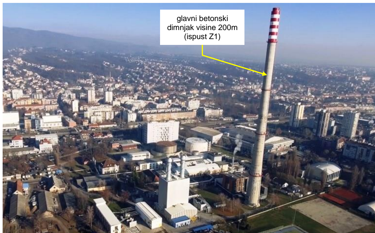
Sl. P 1: EL-TO Zagreb i glavni betonski dimnjak (zajednički ispust dimnih plinova Z1)
