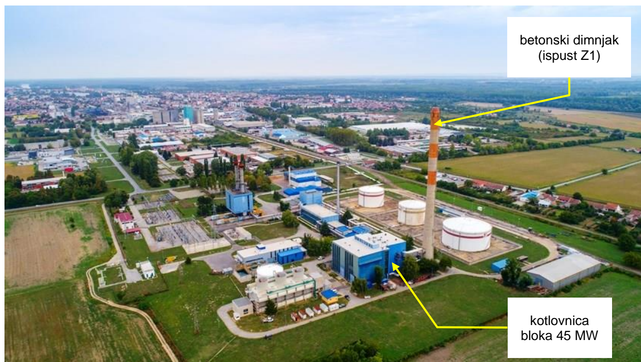
Sl. P 1: Blok 45 MW i zajednički ispust dimnih plinova Z1
