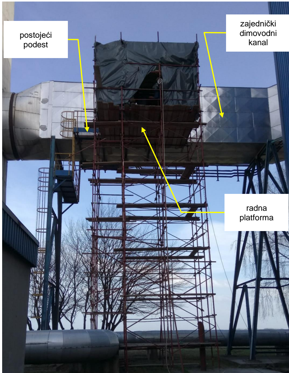
Sl. P 2: Izgled radne platforme
