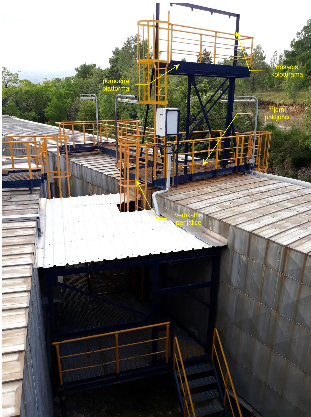
Sl. P 2: Mjerno mjesto prije REA i natkrivena mjerna platforma između dimovodnih kanala
