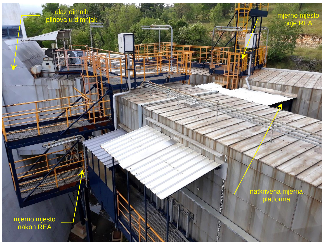
Sl. P 1: Pogleda na mjerno mjesto prije i nakon REA te natkrivenu mjernu platformu između dimovodnih kanala
