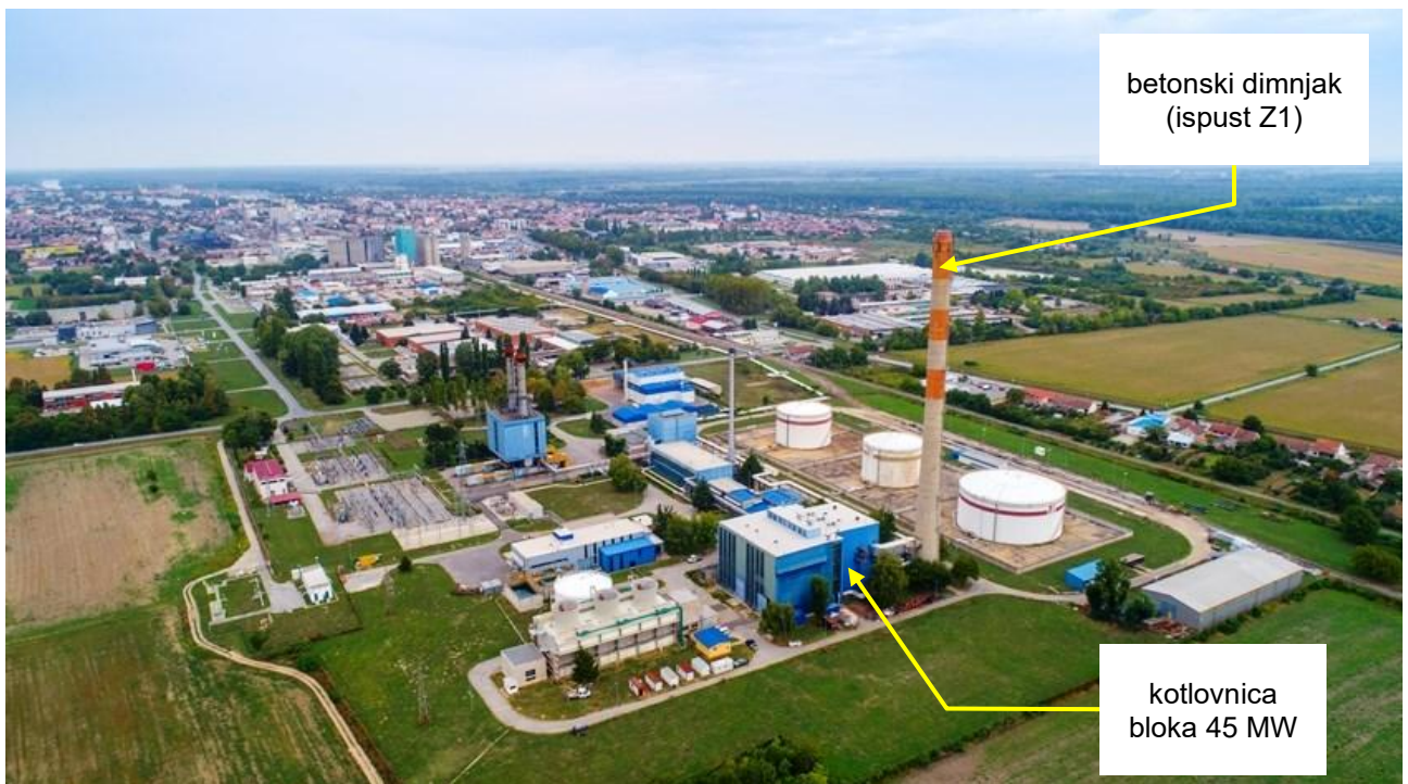
Sl. P 1: Blok 45 MW i zajednički ispušt dimnih plinova Z1
